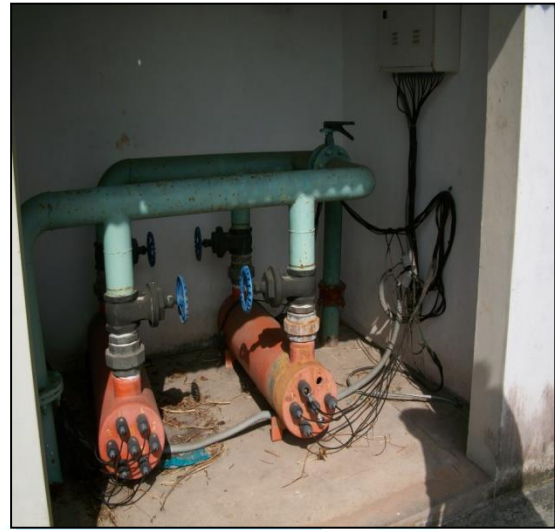
Figura 65 - Reator aeróbio e anaeróbio e sistema UV.
