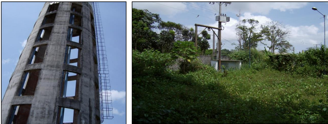
Figura 45 - Caixa d'água e quadros de comando da Unidade Morada de Deus.
