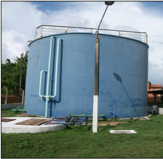
Figura 65 - Reator aeróbio e anaeróbio e sistema UV.
