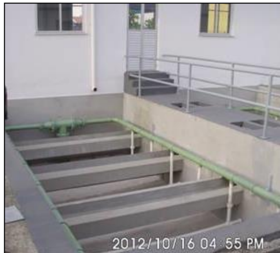
Figura 25 - Filtros reformados.
