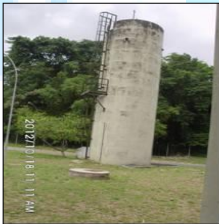
Figura 16 - Tanque de Alívio Unidirecional (TAU) (a); Chegada de Água Bruta na ETA Bolonha (b).
