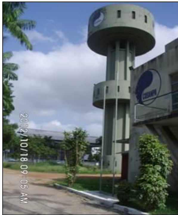
Figura 20 - Reservatório Elevado 5º Setor.
