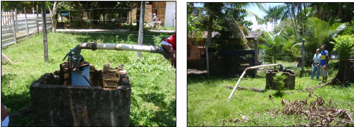
Figura 78 - Captações 1 e 2 da Unidade Farol.
