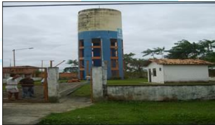
Figura 53 - Reservatório da Unidade Baía do Sol.
