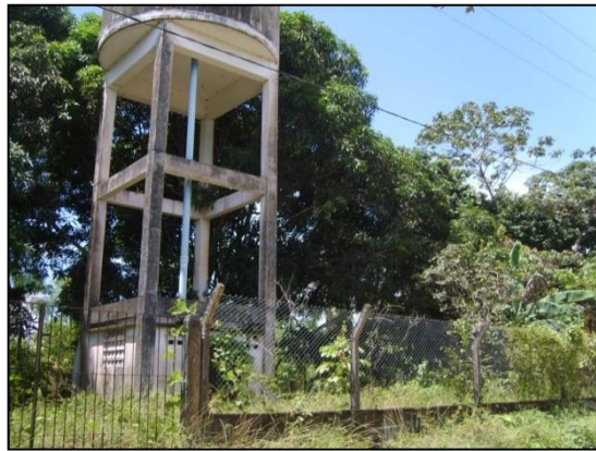
Figura 52 - Torre de operação da Unidade Praia Funda.
