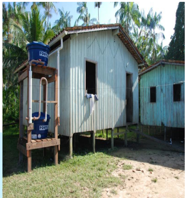
Figura 74 - Sistema de abastecimento com uso da água de chuva instalado pelo GPAC Amazônia/UFPA na ilha Murutucu.
